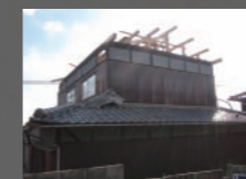
以前の入母屋の屋根は取り払われ新しい屋根が出来ています。
